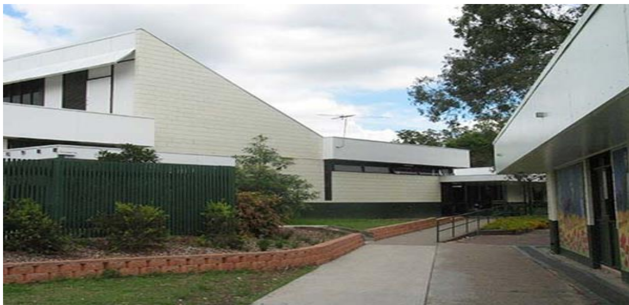
Figura 7 Due degli edifici che compongono l'ampio complesso scolastico
