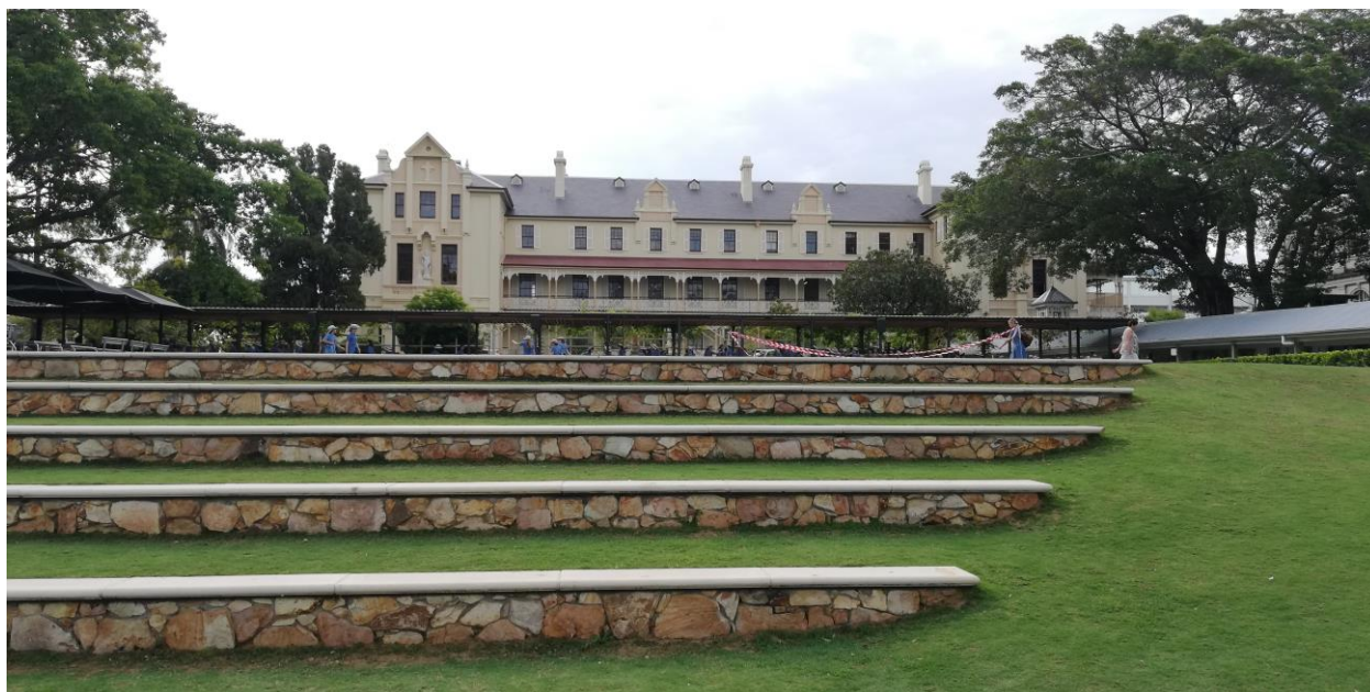
Figura 1 Uno degli edifici del complesso scolastico, sito d'interesse storico locale e regionale
